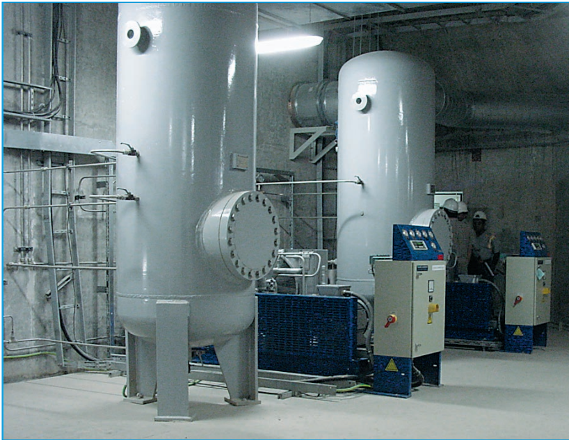
Hochdruckkompressor, zweimal | 23.0-30 für fünf Francisturbinen mit je 250 kW für Projekt Ghazi Barotha, Paskistan ■
